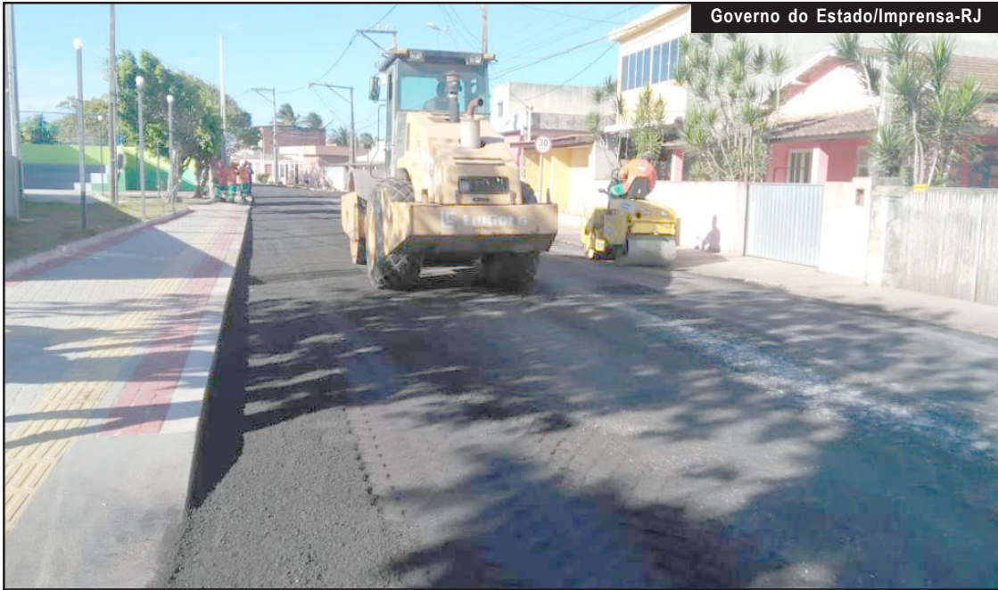
Dezessete cidades já firmaram convênio com o DER para obras em vias
